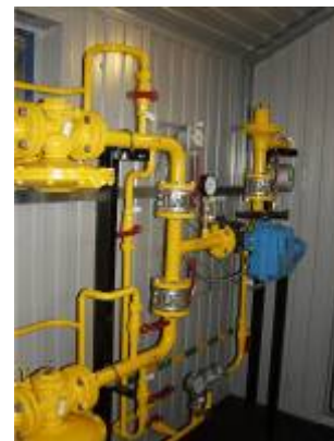
Пункт газорегуляторный блочный с подогревом газа и системой автоматического управления.
