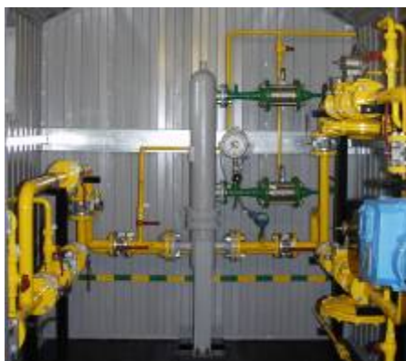
Пункт газорегуляторный блочный с подогревом газа и системой автоматического управления.
